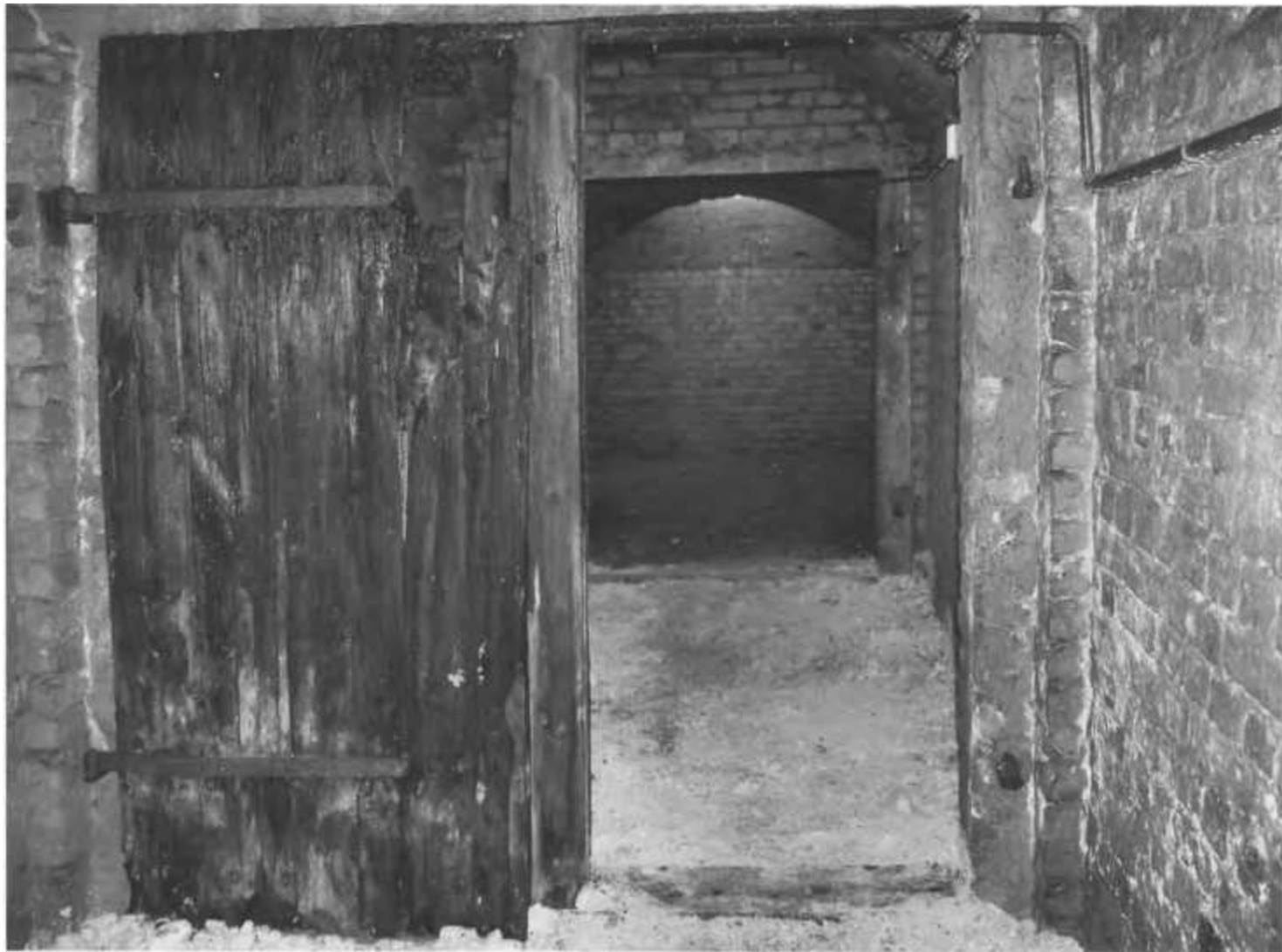
W podziemnych korytarzach pod Górą Parkową – tu miała być śluza
